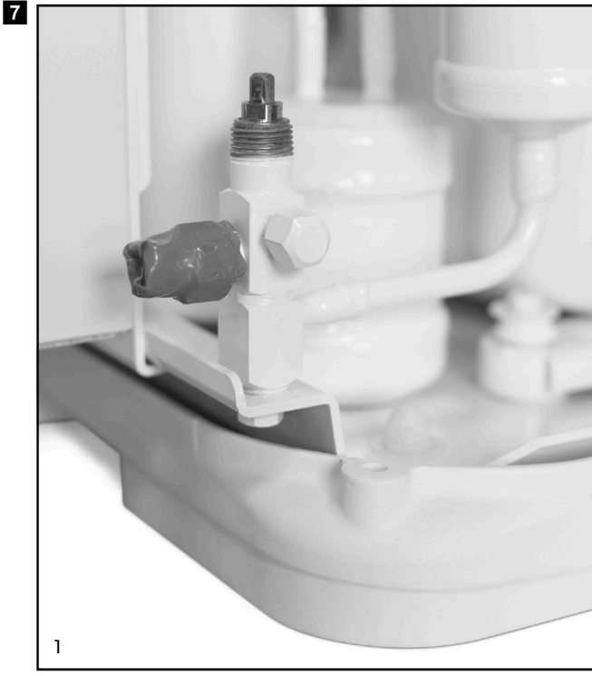
Çizelge 212: Servis vanaları öne oturtulmuş konumda gösterilmiştir
